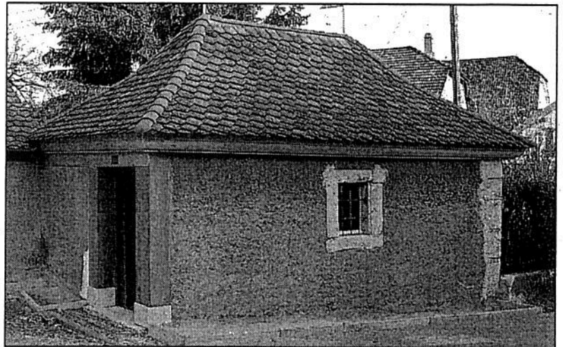
Zollhüsli Die Renovierungsarbeiten am unter Denkmalschutz stehenden Bauwerk sind beinahe abgeschlossen. ZVG
